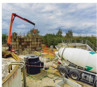
La construction d'un bassin de stockage restitution est actuellement en cours sur le site de la station d'épuration de Méré.
