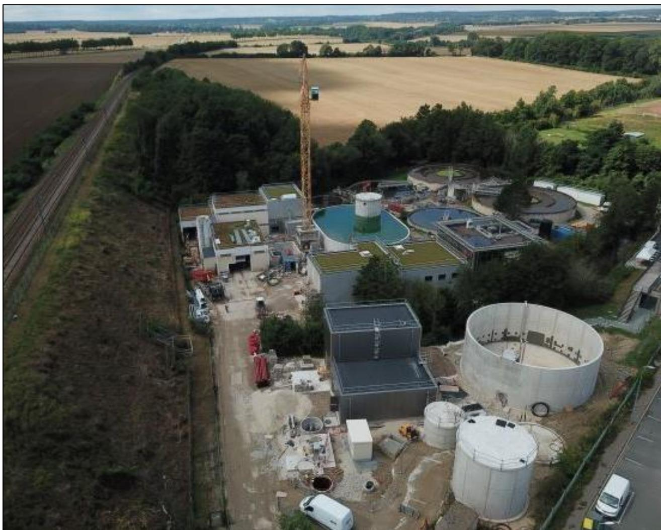
**A noter que les travaux de restructuration de la station d'épuration ont débuté en 2020 entrainant la réhabilitation de plusieurs ouvrages de la filière de traitement (pré-traitement, traitement des boues avec la mise en service d'un méthaniseur et production de biogaz, bassin écreteur).**
