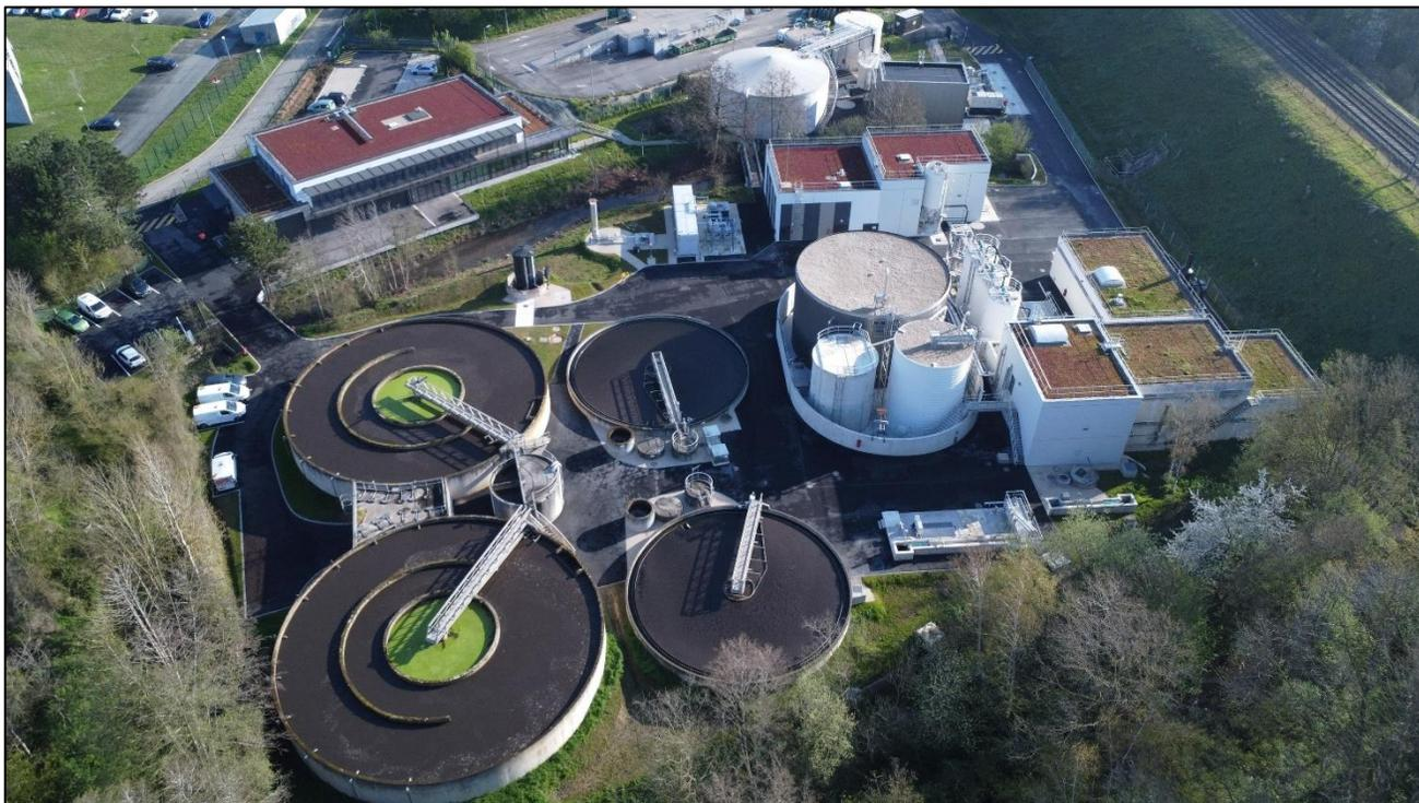
A noter que les travaux de restructuration de la station d'épuration ont débuté en 2020 entraînant la réhabilitation de plusieurs ouvrages de la filière de traitement (pré-traitement, traitement des boues avec la mise en service d'un méthaniseur et production de biogaz, bassin écréteur). Ils ont été réceptionnés en janvier 2023.
