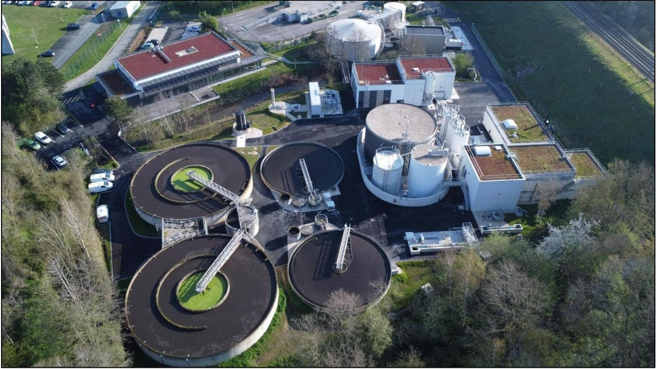
À noter que les travaux de restructuration cette station d'épuration débutés en 2020 ont consisté en la réhabilitation de plusieurs ouvrages de la filière de traitement (pré-traitement, traitement des boues avec la mise en service d'un méthaniseur et production de biogaz, bassin écréteur). Ils ont été réceptionnés en janvier 2023. La capacité de la station d'épuration a été portée à 42 000 EH.
