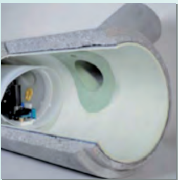
Réouverture et étanchéité d'un branchement (chemisage)
